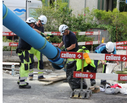
Die Mitarbeiter der GWS beim Einziehen der neuen Gusseisen-Trinkwasserrohre.
